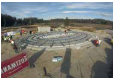
Ebene Betonplatte mit Aussparungen vor dem „Aufblasen“.
