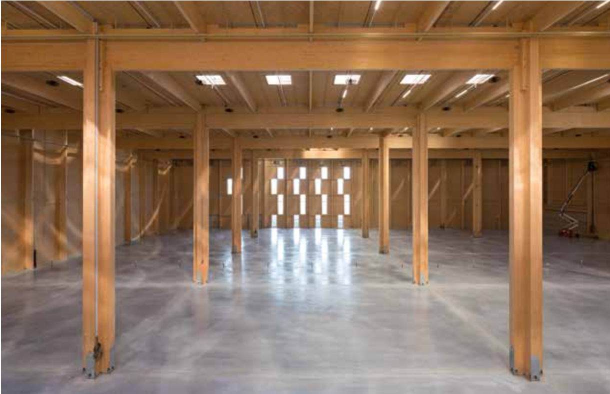
Rund 16 Meter hohe Stützen mit einem Querschnitt von 150 x 150 Zentimetern bilden das tragende Gerüst der Holzbauhalle.
