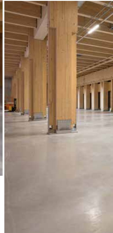
Rund 16 Meter hohe Stützen mit einem Querschnitt von 150 x 150 Zentimetern bilden das tragende Gerüst der Holzbauhalle.
